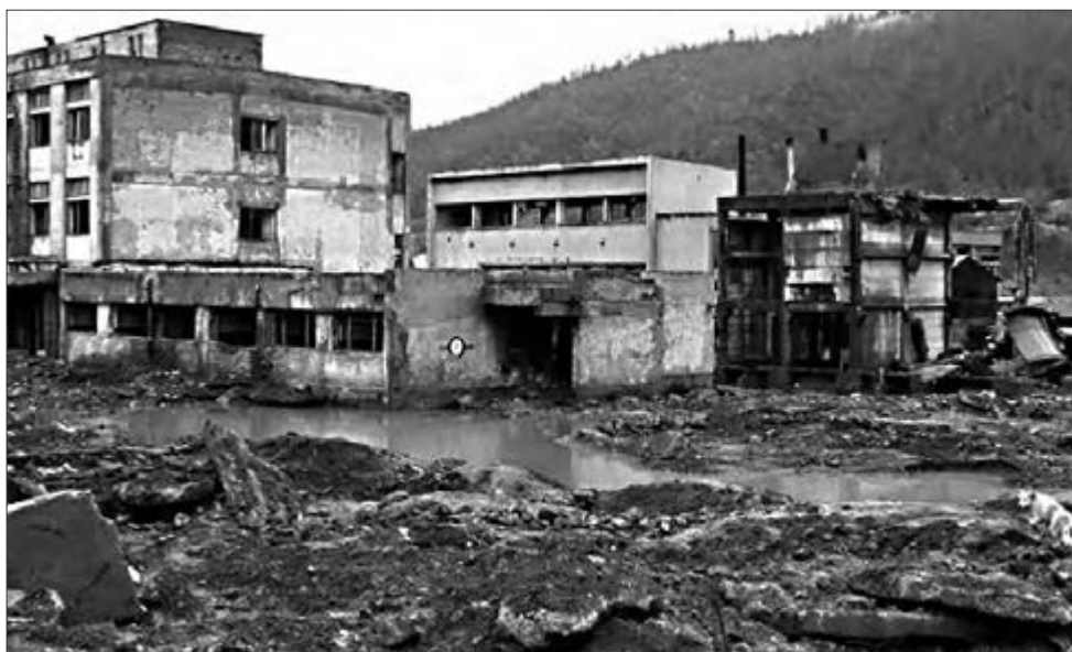
Verlassene Häuser im Karpatendorf Roșia Montană/Rumänien - Dort soll zukünftig unter Verwendung giftigen Zyanids Gold gefördert werden - trotz der zu befürchtenden Schäden für Mensch und Umwelt.
